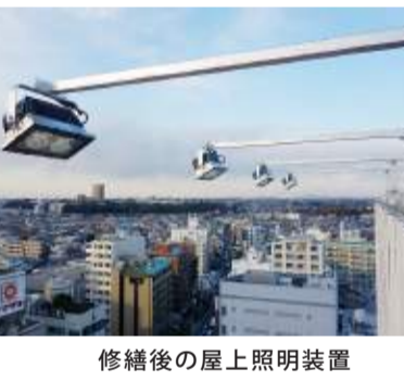
修繕後の屋上照明装置
