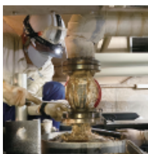
ボイラー修繕工事の様様
