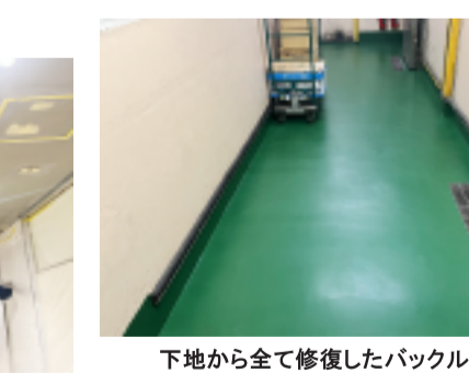
下地から全て修復したバックルーム床
