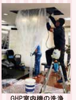
GHP室内機の洗浄
